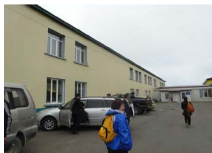
鉄骨二階建て
